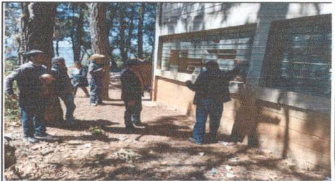
Foto 2: observando los vidrios dañados los cuales se van a cambiar
